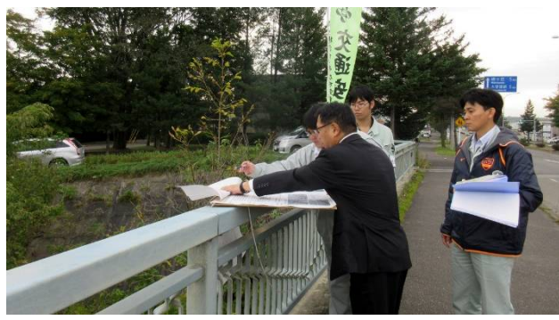
監査委員として工事現場を調査(10月11日)
